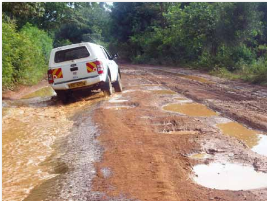
Stora hål i vägbanan på asfaltvägar, s.k. "pot holes", djupa fåror uppkomna efter häftig nederbörd med erosion och sliriga sandvägar är inget ovanligt.
